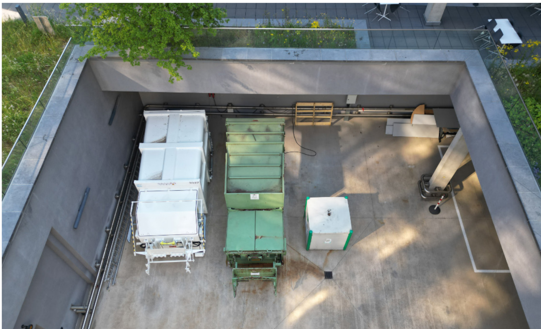
Figure 12 – Zone des déchets du quai de livraison
